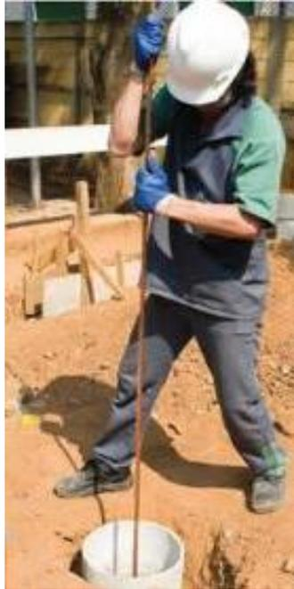
**Figura 1- Instalação da haste de aterramento**
