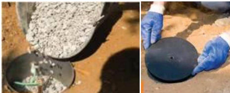
**Figura 3- Finalização da instalação do aterramento externo**
