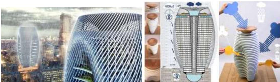
Sob a superfície da cobertura, existem reservatórios de água sob a forma de um grande funil e plantações de cana, que servem como uma unidade de tratamento hidro-botânicos de água. A unidade processa a água da chuva em
