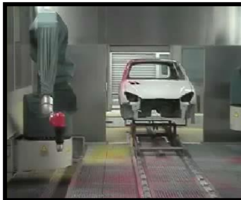
Figura 04: Cabine de Pintura
