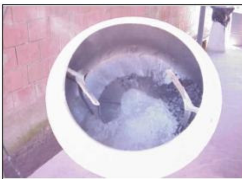
Figura 9. Inicialização do processo de mistura do concreto.
