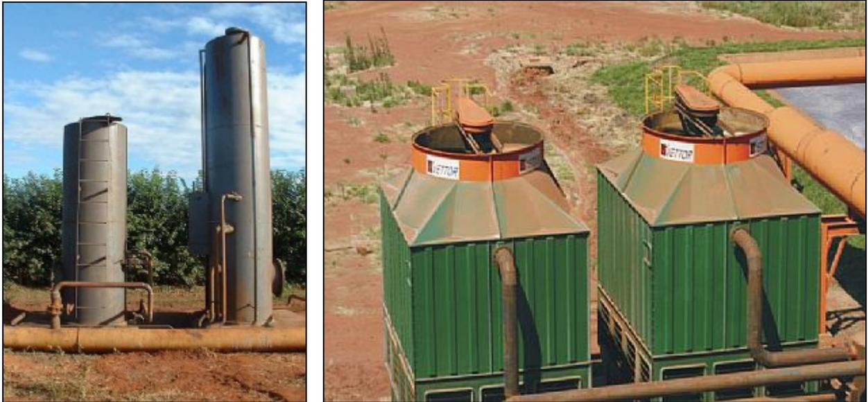
Fig. 04 – 05 - Sistema fechado de captação e resfriamento de água
