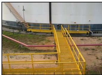
Figura 2: Passarela. Fonte - Gerência da Engenharia da refinaria.
