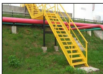
Figura 1: Escada e guarda-corpo. Fonte - Gerência da Engenharia da refinaria.
