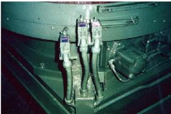
Figura 10: Situação atual das bombas. Fonte: cortesia da empresa (impressão).
