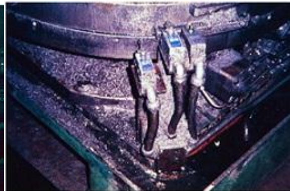
Figura 11: Situação anterior das bombas. Fonte: cortesia da empresa(impressão).
