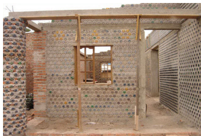
Fase de construção da casa
