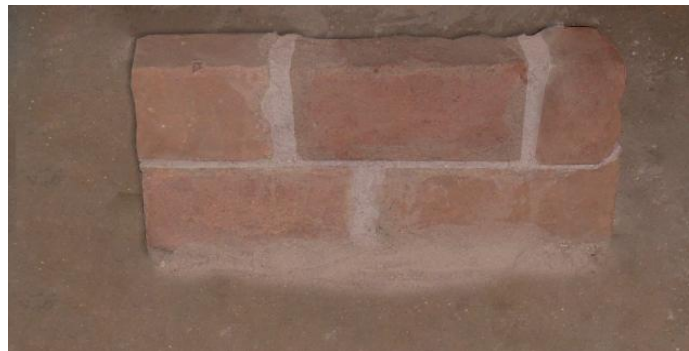
Figura 3.1 – Trecho experimental de alvenaria de tijolo maciço assentado com a “argalama”.
