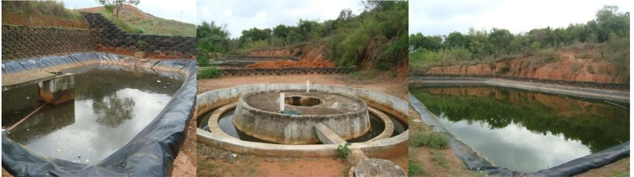
Figura 04: Lagoa anaeróbica, filtro de drenagem e lagoa de polimento.
