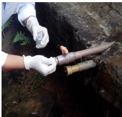
Figura 3:- Ponto de coleta(2) Cisterna
