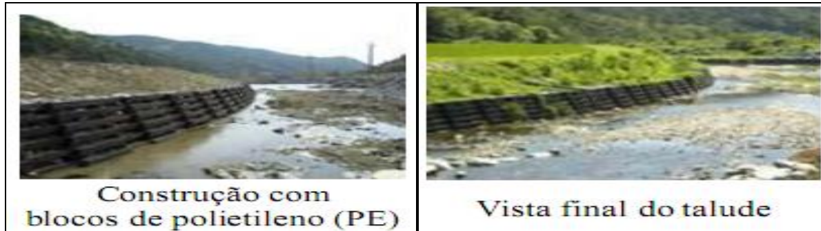
Fig. 28 – Controle de erosões em canais
