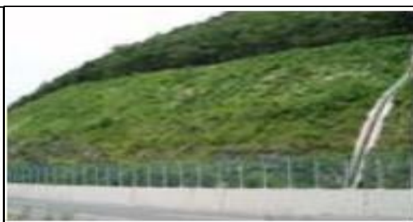
Fig. 27 – Vista Final do Talude
