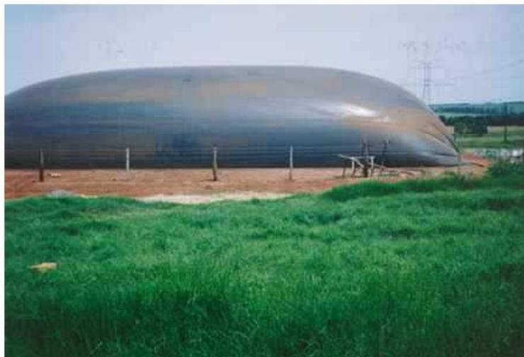
**Figura 5: Biodigestor modelo canadense.**
