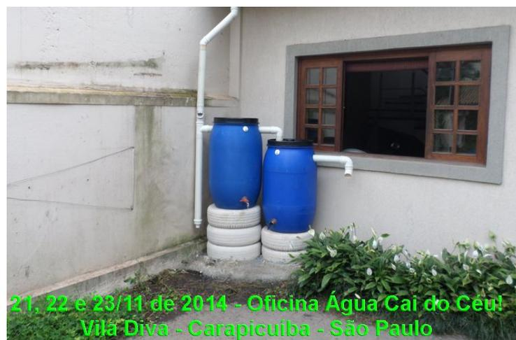
Figura 7 - Exemplo de sistema de captação de água. Fonte: [www.sempresustentavel.com.br](http://www.sempresustentavel.com.br)
