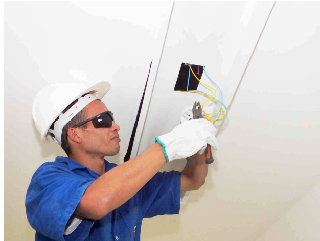
Figura 9 - Substituição da luminária na sala de aula
