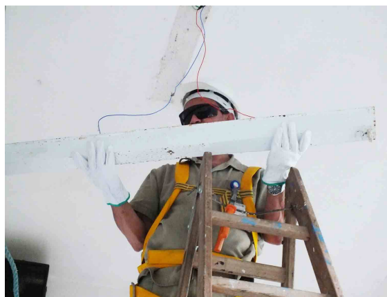
Figura 51 – Substituição das lâmpadas do hall de acesso
