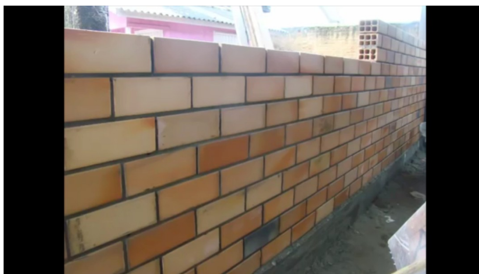
Figura 3 – Alvenaria com uso de gabarito
