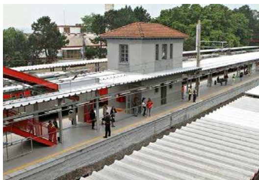
FIGURA 10: Estação Poá – Acesso somente por escadas
