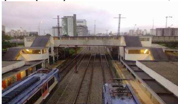
FIGURA 7: Estação Prefeito Saladino – Acesso por escadas
