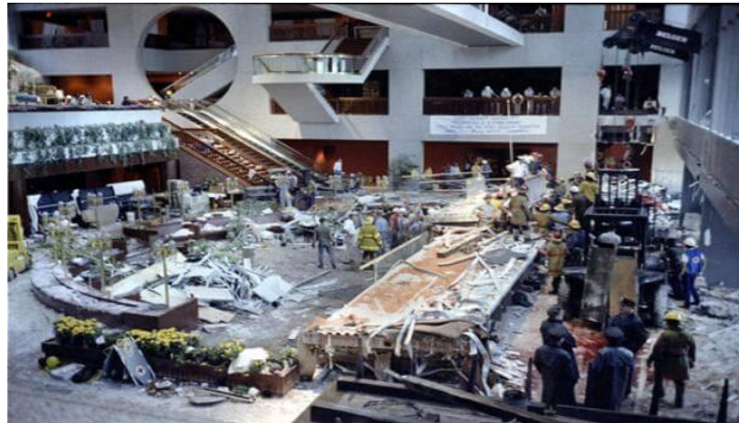
Figura 3: Queda da passarela do Hyatt Regency
