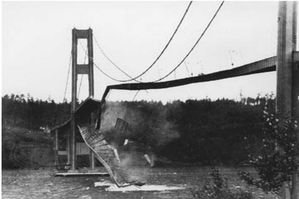
Figura 2: Desestruturação do vão e queda da ponte
