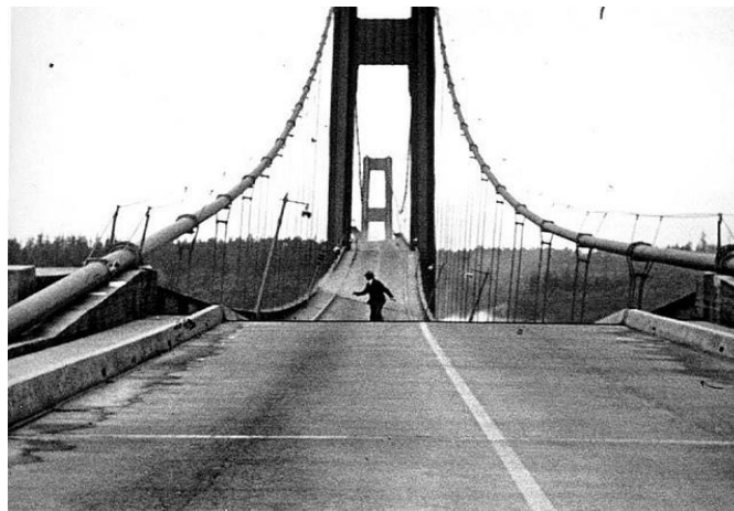
Figura 1: Homem na Ponte de Tacoma enquanto ela oscila
