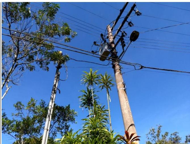
**Figura 1:** Transformador de uso exclusivo da residência.
