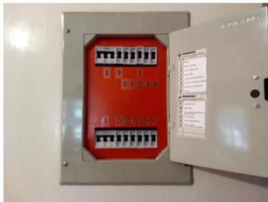
**Figura 2:** Quadro Geral de Distribuição de Carga.
