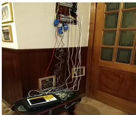
**Figura 16:** Conexão do registrador no QGDC.
