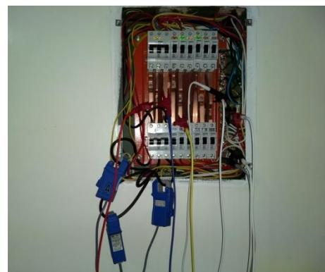
**Figura 17:** Detalhe da conexão das garras.
