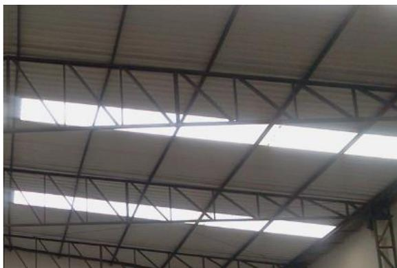
**Figura 4:** Telhas onduladas translúcidas de policarbonato instaladas
